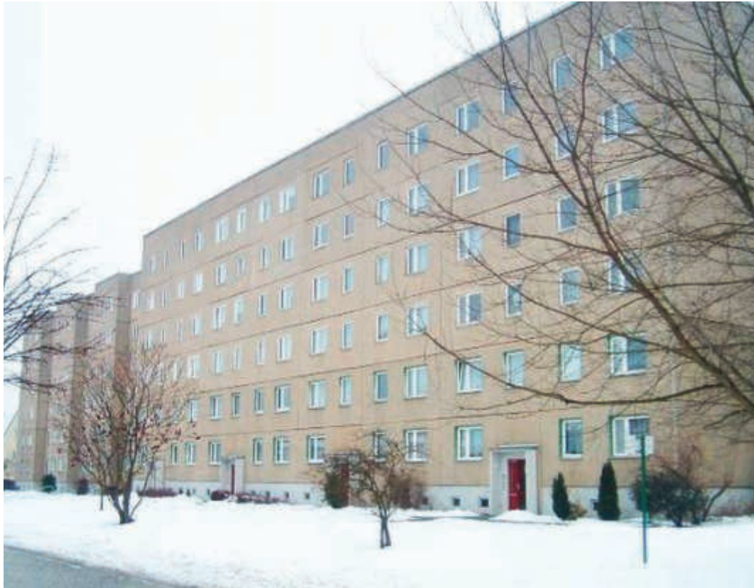
Kohleersatzbau- wohnungen in Spremberg
